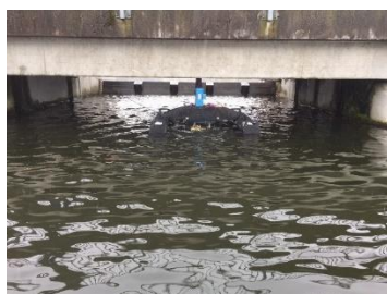
OLOID Typ 400 mit Strömungsrichtung zur Wehrklappe
